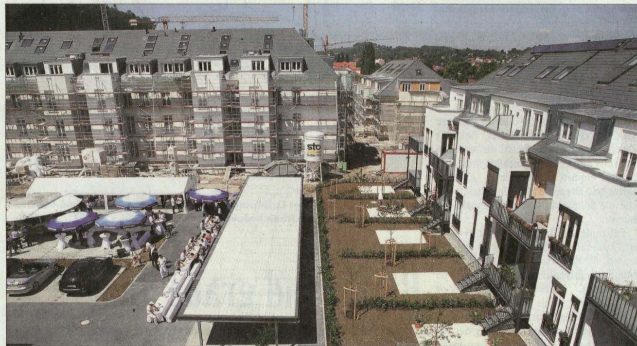
Grundlegend saniert und energieeffizient: Aus Kasernenbüros werden Wohnungen. FOTO: CHRISTOPH BREITHAUPT
