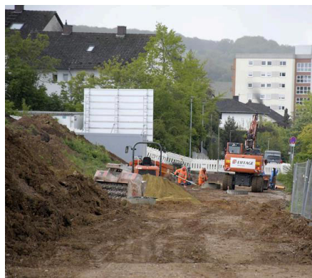
Hier der Blick in die Verlängerung zur Humperdinckstraße. (© Isabel Mittler)
